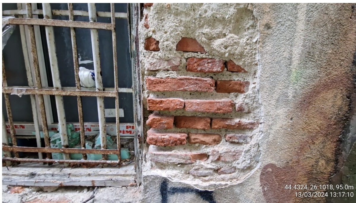
Figura 5 – Tencuieli și zidărie depreciată din cauza evacuării incorecte a apelor pluviale,
