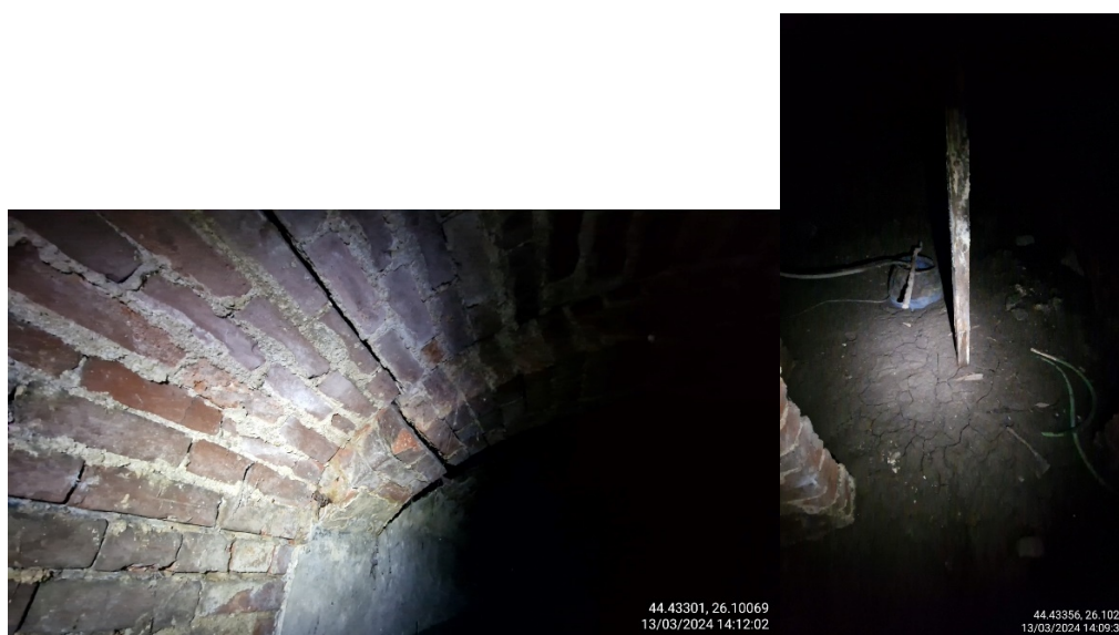
Figura 7 – umiditate prezentă în pereții subsolului, pământ umed la nivelul pardoselii subsolului
