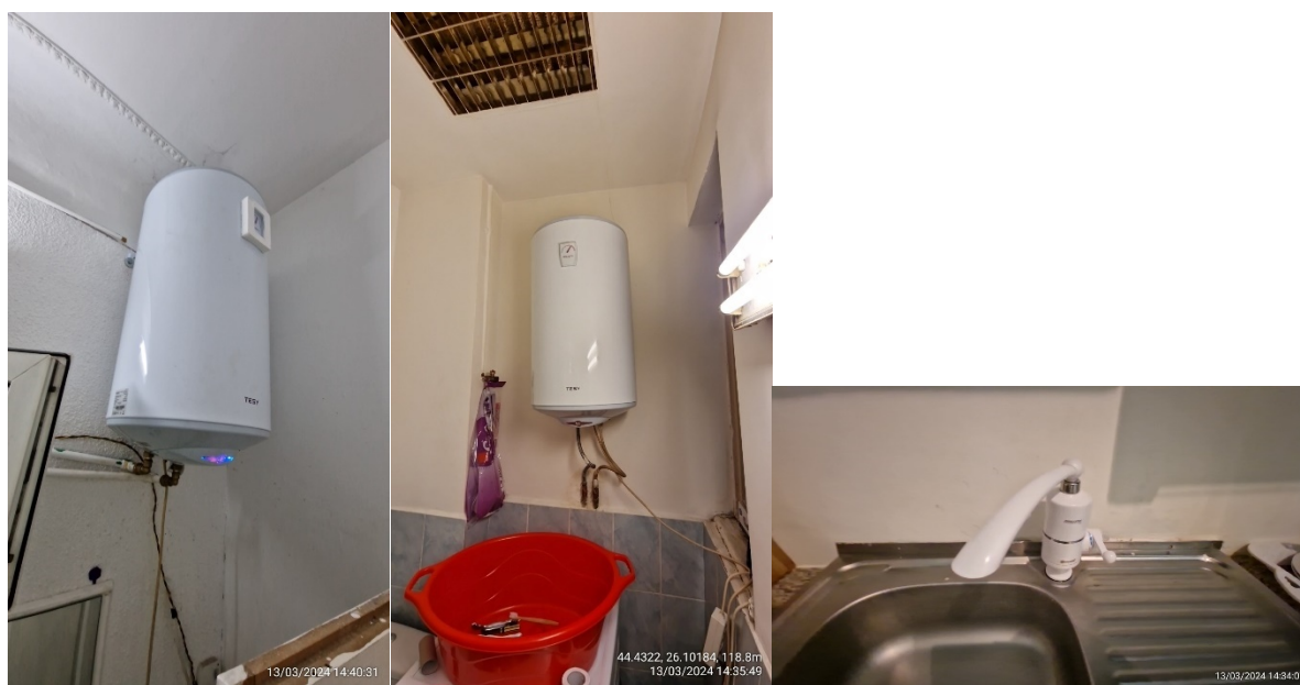
Figura 11 – boilere electrice sau aparate de tip instant electric pentru preparare a.c.c.
