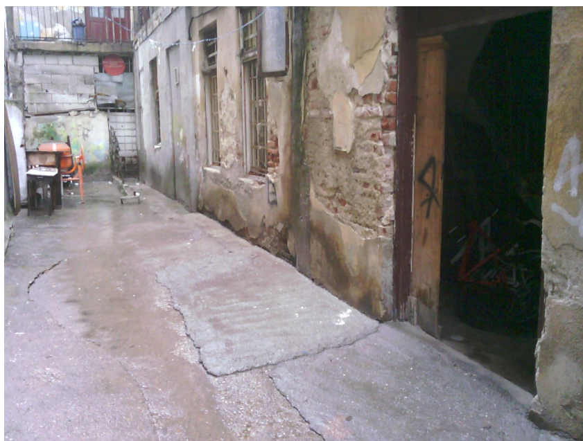
Figura 20 – Fațada către curte interioară. Zonele marcate în imaginea de mai sus sunt zone umede, datorate sistemului deprecat de preluare și evacuare ape pluviale de la nivelul invelitorii și de la nivelul solului. Acest fapt a dus și la deprecierile vizibile pe pereții exteriori. Pe această fațadă, nici un spațiu interior vizibil în această imagine nu este încălzit.
